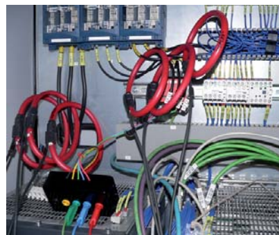
> Rogowského cívky pro měření AC 50 Hz třífázových elektrických výkonů
